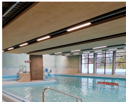
Provisorische Decke und Beleuchtung
